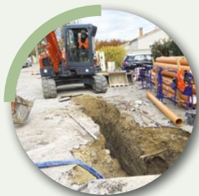
Rénovation du réseau d'assainissement chemin de la Lône page 4
