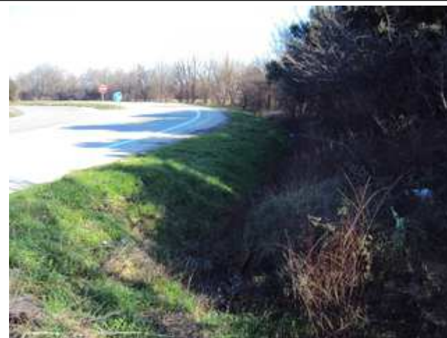
Photo N° 4 Bretelle RD942 – Entraigues sur la Sorgue
