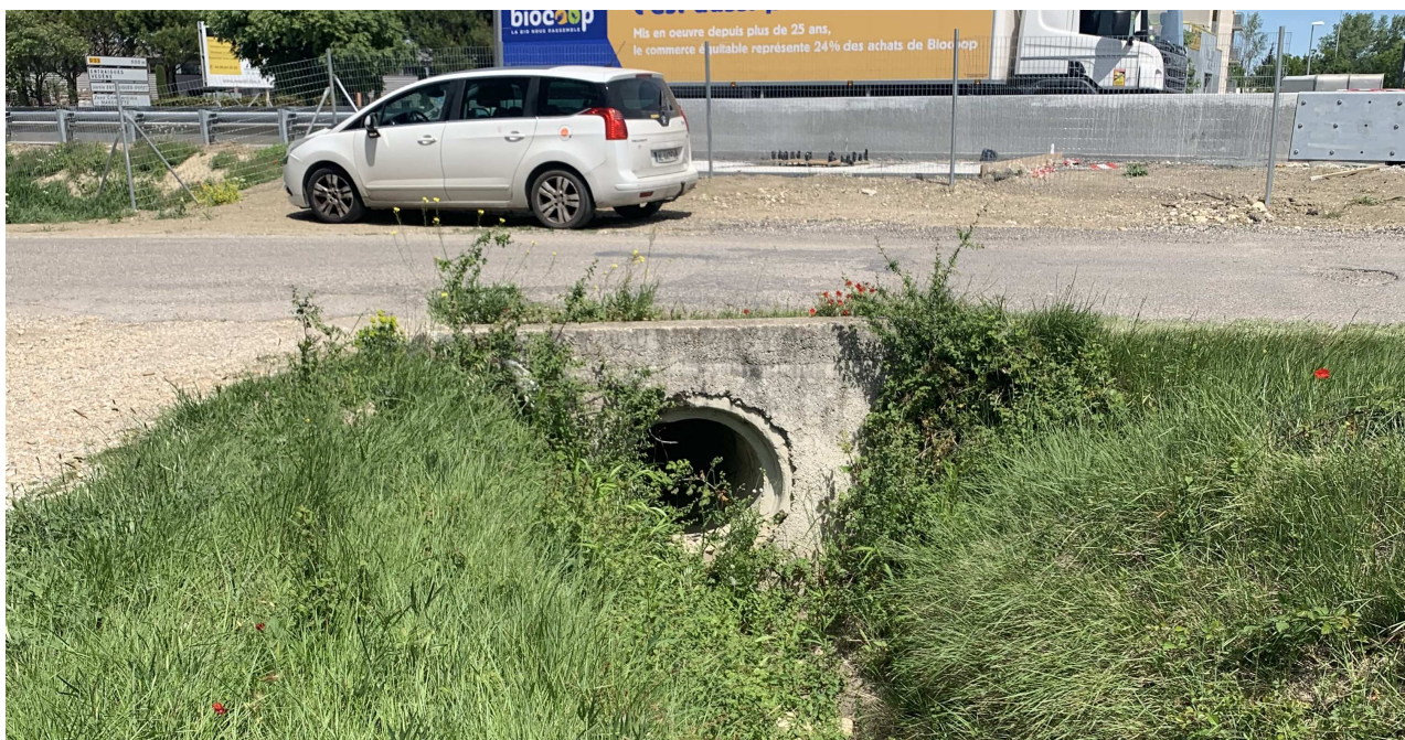
Passage de la Mayre de Malpassé sous la RD942
